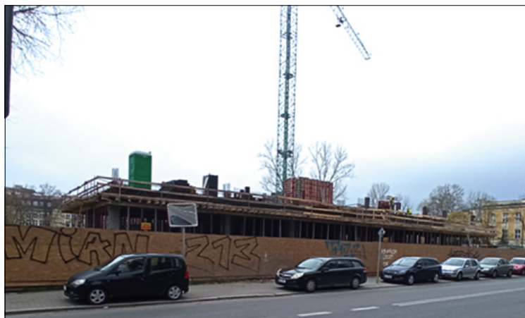
Budowa apartotelu przy ul. Grenadierów 41, kwiecień 2023 r.
