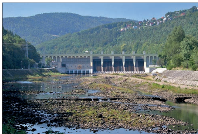
Ryc. 15. Zapora Porąbka na rzece Sole (fot. Roman Kujawa)
