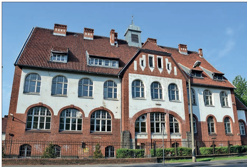
Ryc. 1. Budynek przy al. Powstańców Wlkp. 2 w Bydgoszczy – do 1935 r. siedziba Wydziału Higieny Zwierząt. Widok w 2012 r. (fot. J. Judek)
